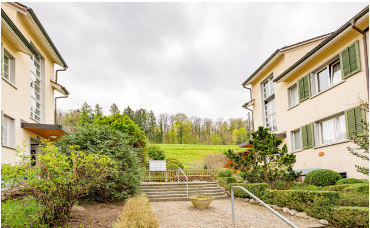
Neue Liegenschaften an der Winterthurerstrasse 412 und 414 in Zürich-Schwamendingen
