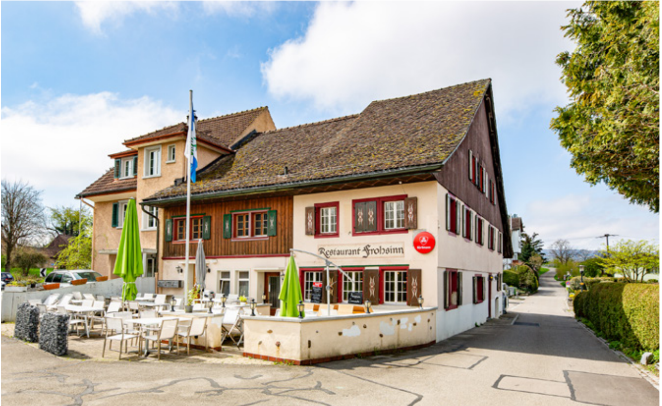
Neue Liegenschaften an der Gfennstrasse 22 und 24 im Gfenn bei Dübendorf
